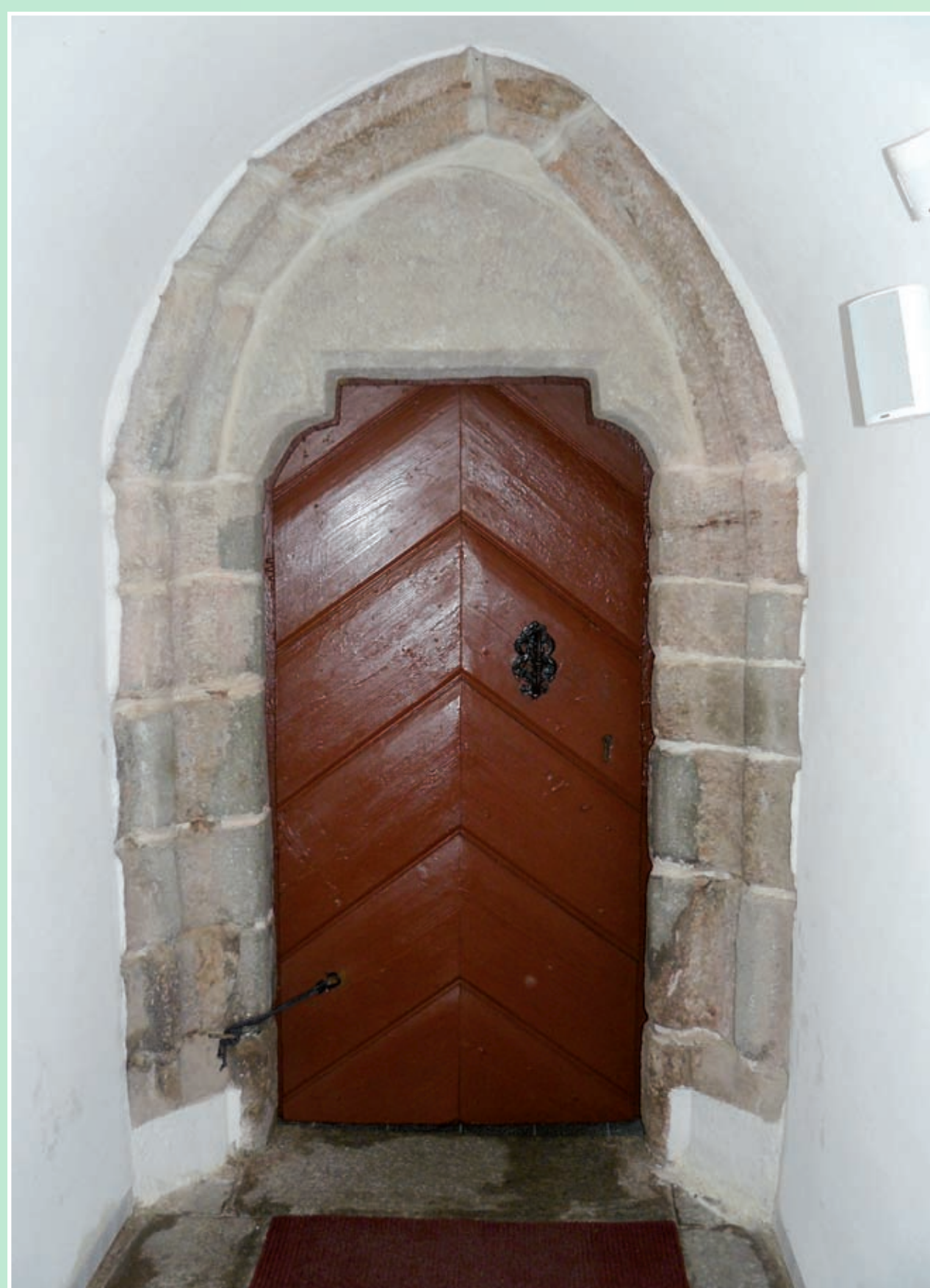
Kamenný sedlový gotický portál
