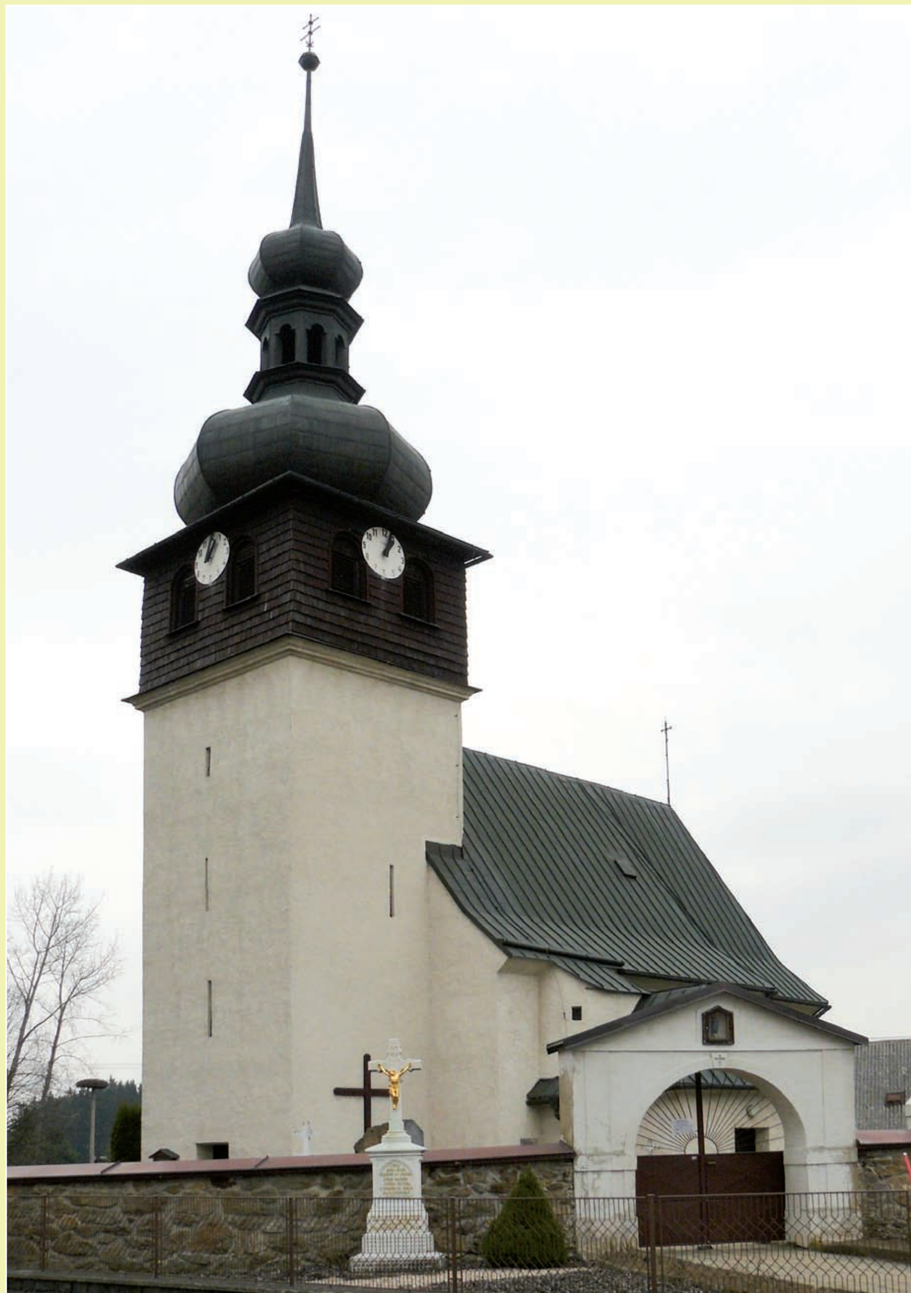
Celkový pohled na kostel
