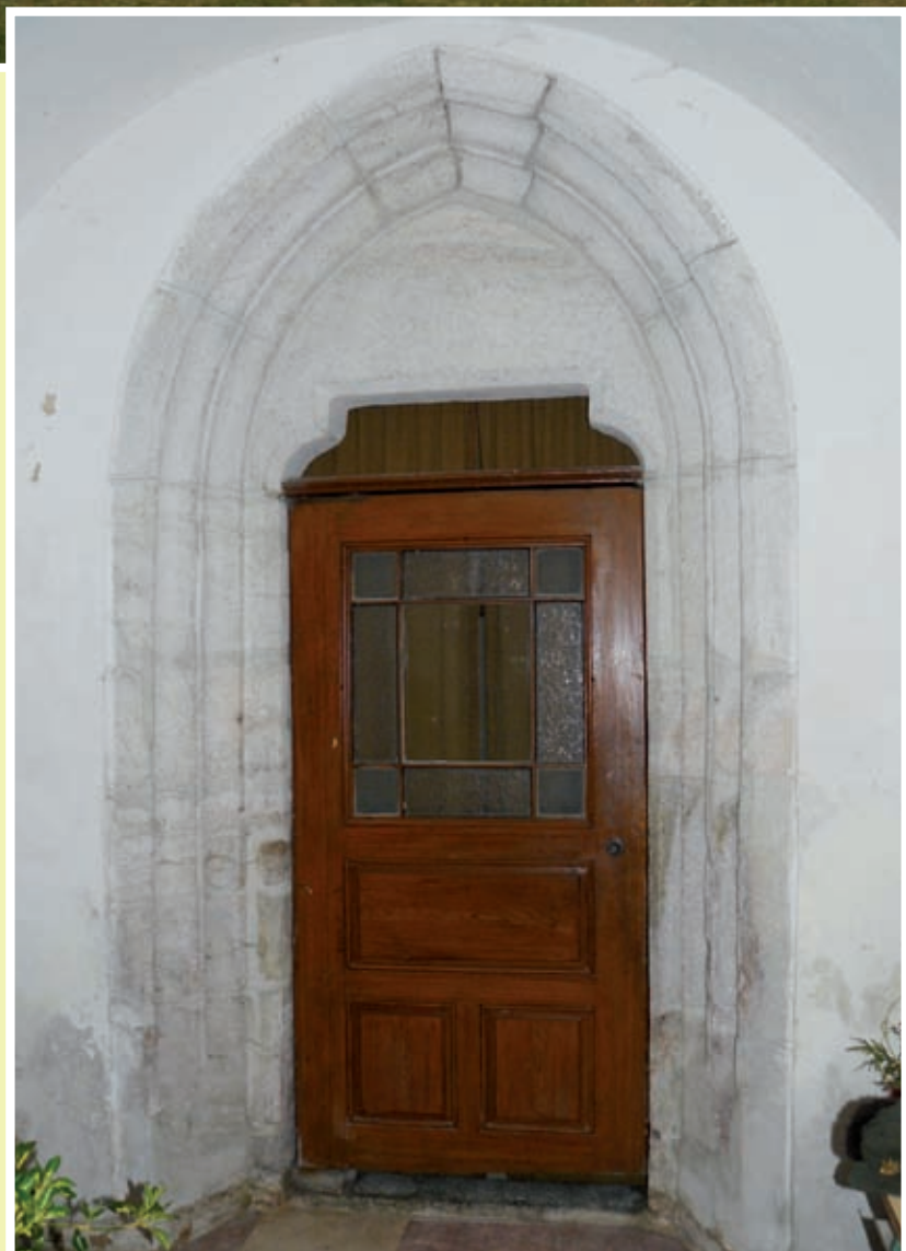
Vstupní gotický portál u bočního vchodu
