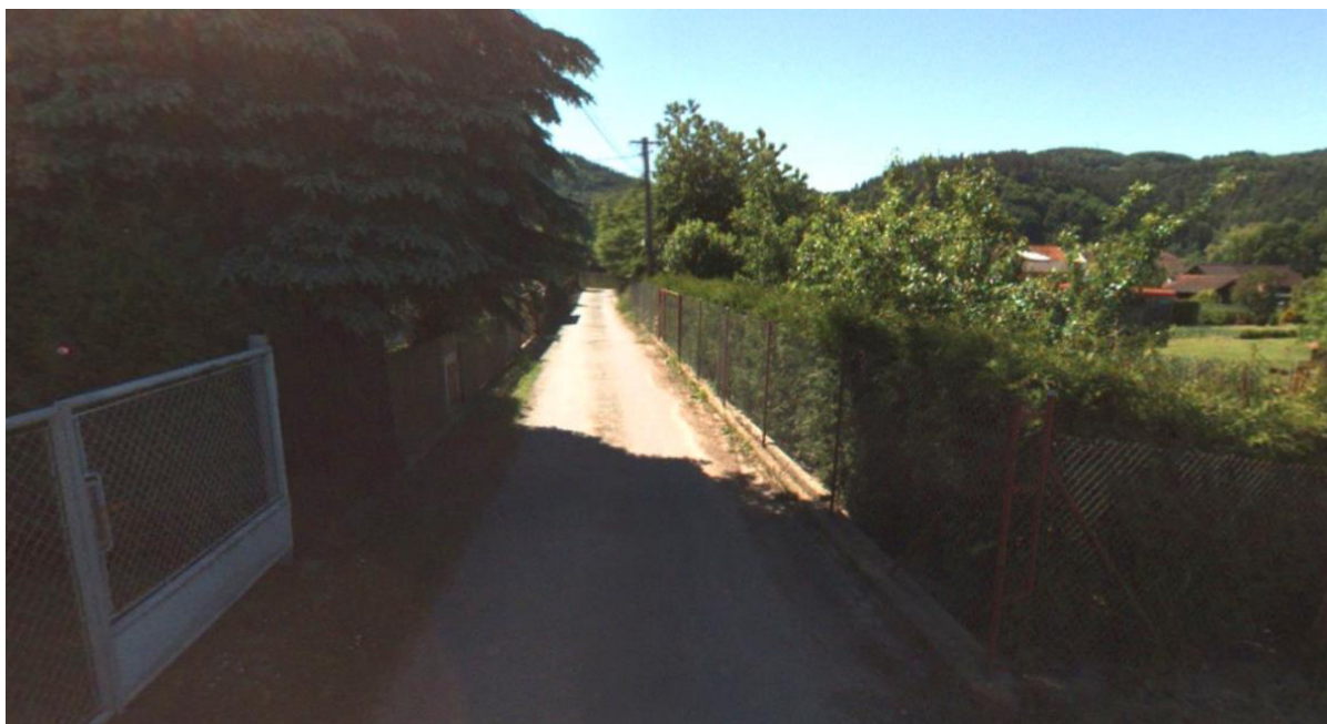
Ilustrační foto – příklad opomenutí zajištění dostatečných přístupových koridorů pro novou výstavbu v územním plánu (Štěpánov na Svratkou)
