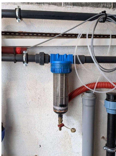
Obr.1: FH(S3) je trubicí filtr instalovaný přímo na přívodním potrubí pro filtraci hrubých nečistot ze zdrojů vody s max.průtokem 3000l/hod.
